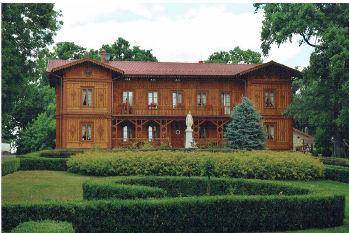
Fot. 2 Drewniana willa powstała w XIX w. w Mircu wpisana do Gminnej Ewidencji Zabytków
