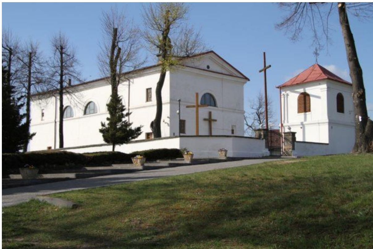
Fot. 3 Kościół Parafialny w zespole kościoła parafialnego pw. Św. Leonarda w Mircu wpisany do Gminnej Ewidencji Zabytków
